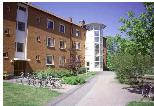
Ascensore aggiunto all'esterno della facciata
