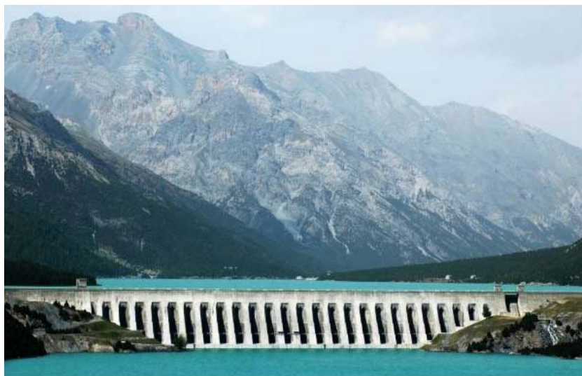
La diga di San Giacomo, in Val Fraele (Sondrio) (Foto archivi A2A)
