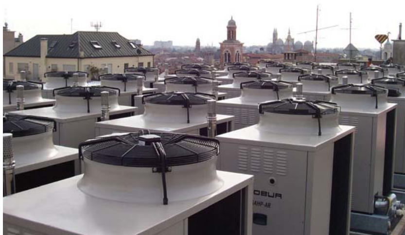
Installazione a tetto delle pompe di calore (Foto archivi Robur)
