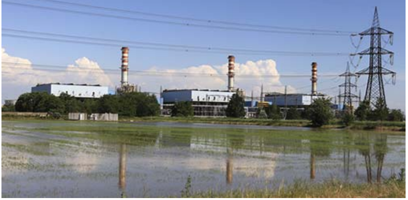
L'impianto EniPower di Ferrera Erbognone (Pavia) (Foto archivi EniPower)
