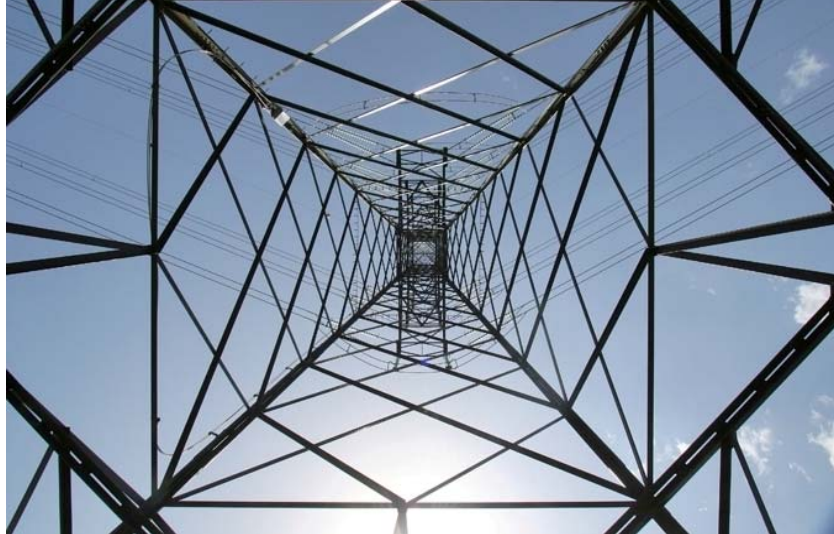
Particolare di un traliccio, visto dal basso
